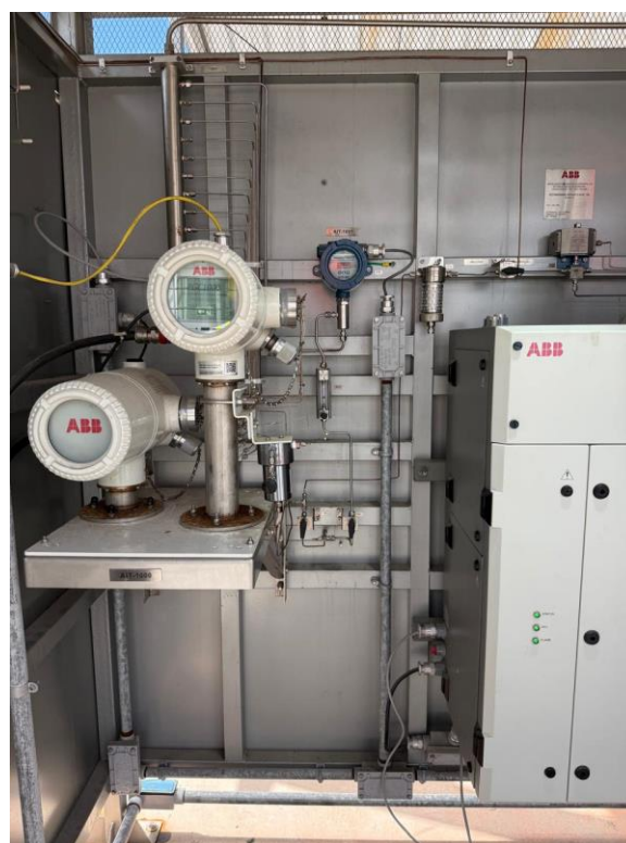
Foto 6.2-2: Cromatógrafo ABB (AIT-1000) para análise da composição do biogás (Fonte: BV, maio/26).
