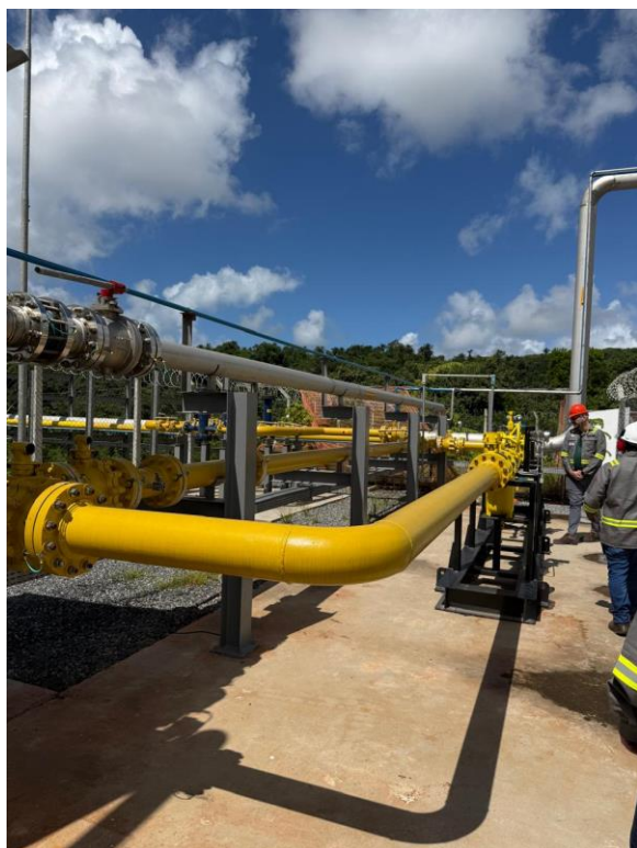
Foto 6.2-5: Dutos amarelos de condução do biometano para entrega à concessionária (Fonte: BV, maio/26).
